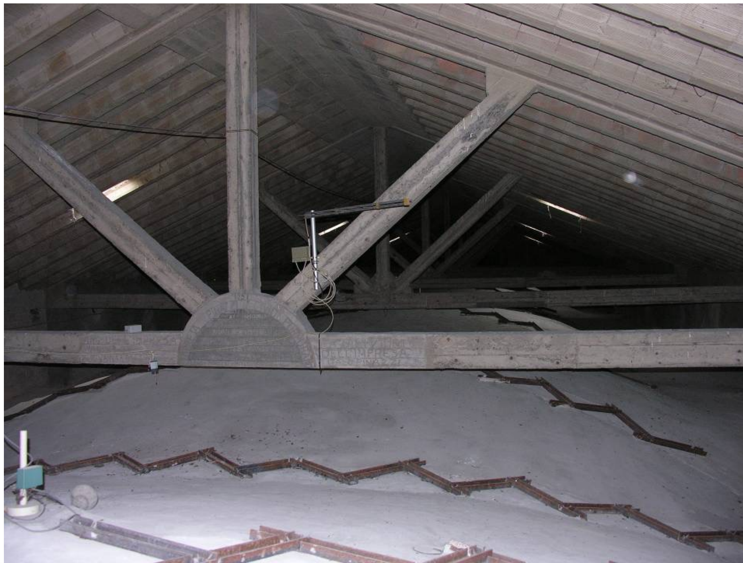
Duomo di Parma, capriate lignee sostituite con capriate in c.a.
